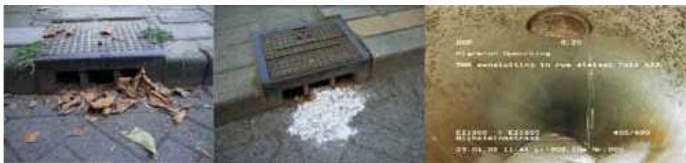
Figuur 6: Diverse bronnen: bladval (nutriënten), lozingen (diverse stoffen) en rechts foutieve aansluitingen (inspectiefoto van regenwaterriool).
